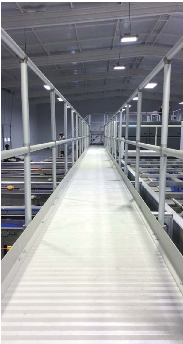
Bridge for Sorting Machine 分拣设备过线梯
