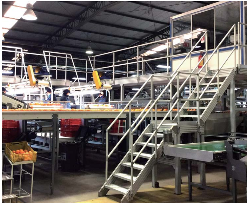
Bridge for Sorting Machine 分拣设备过线梯
